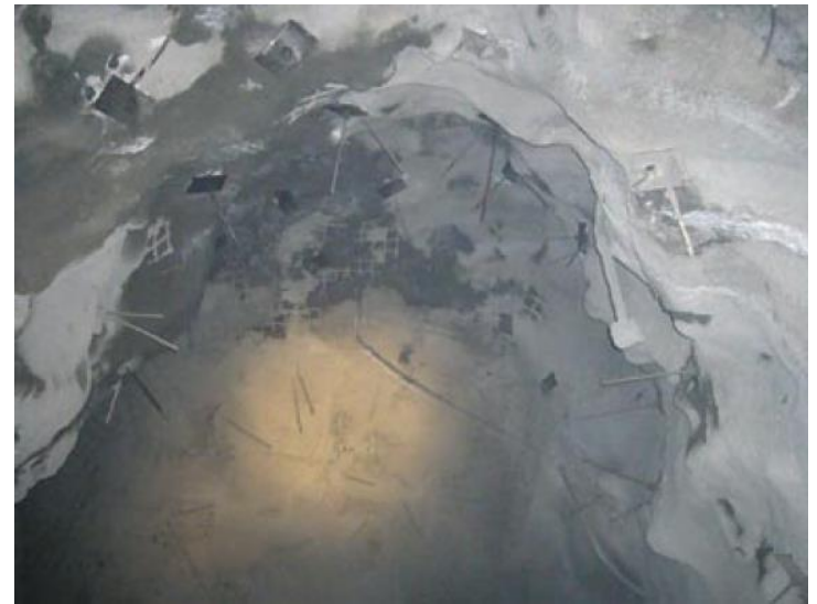
Tunnelikatton sortuma pysäytetty pinnoitavalla lujituksella (kuituruiskubetonointi –verkotus-kiikapultitus, aluslevyllinen vaijeripultitus); Lähde:Hituran Kaivos
