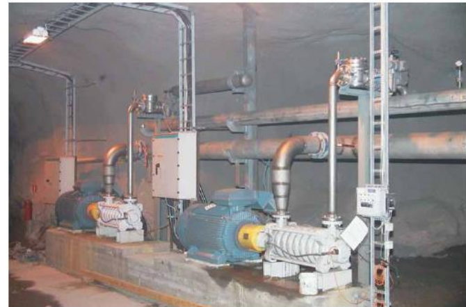
Pyhäsalmen kaivoksen +645-pumppaamo
